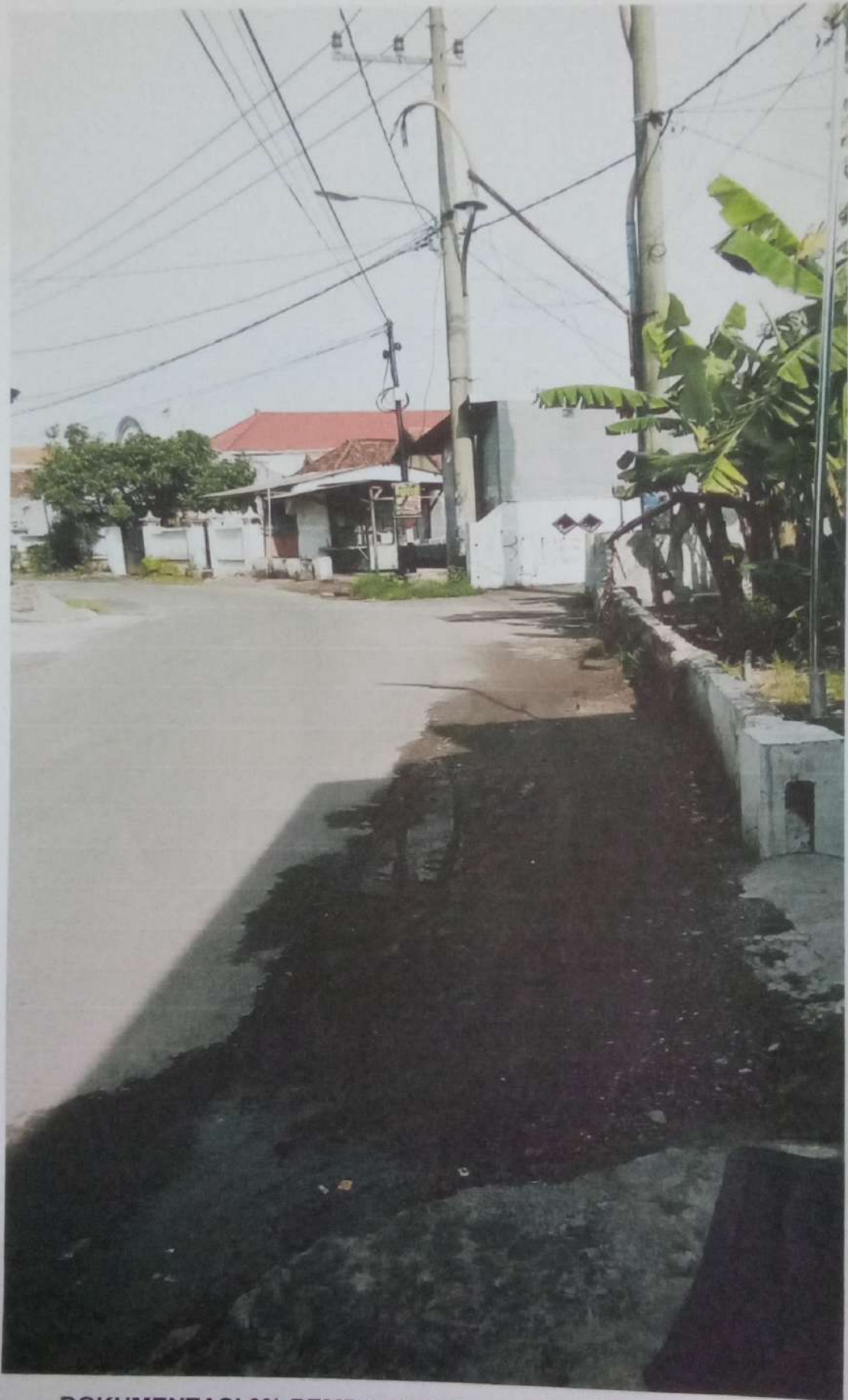
DOKUMENTASI 0% PEMBANGUNAN SALURAN AIR DENGAN U-DICTH REHABILITASI JALAN ASPAL DSN PANJUNAN RT:01,02,03 & 04 RW 01 DS PANJUNAN
