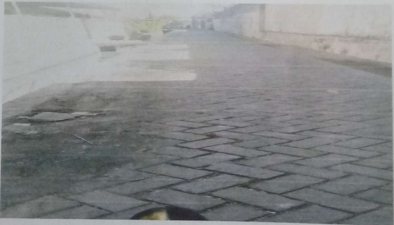
15. Perbaikan Jalan Paving RT 11 RW 03
