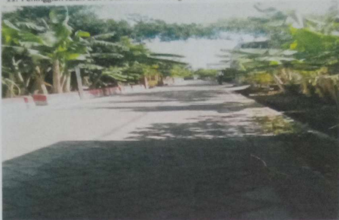
11. Peninggian Jalan dan Penambahan Paving RT 08
