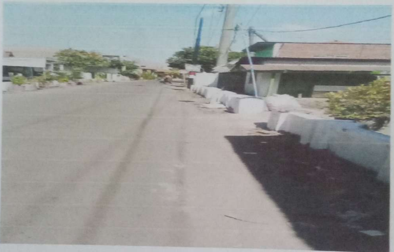
7. Pembuatan Saluran Air dengan U-Ditch Plus Tutup RT 05 RW 02 dan RT 04 RW 01
